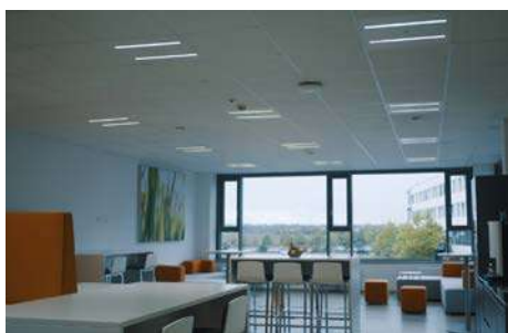
تنظیم نور خروجی براساس نور محیط (کم نور بودن چراغ‌های نزدیک به پنجره)
